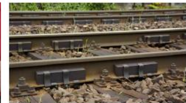
Abbildung 55: Schienenstegdämpfer im Verlauf der Elbaltstrecke.
