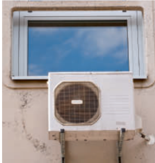
Außeneinheit eines Splitgerätes
