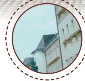
PV-Anlagen auf Dächern
