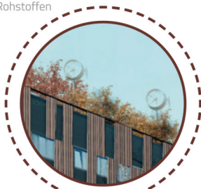
Extensive Dachbegrünung mit Kleinwindanlagen und PV
