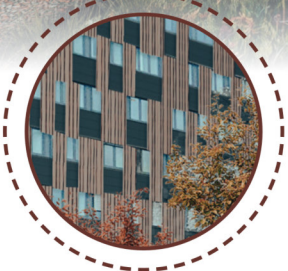
Fassadenerneuerung mit PV-Fassadenelemente und Holzlamellen zur externen Beschattung und Bindung von Co 2 in Rohstoffen
