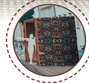
Bushaltestelle mit Fassade aus Insekten-Nist- und Überwinterungshilfe
