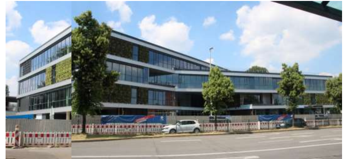
Rechts: Stand der Fassadenbegrünung 11. März 2024 Unterkonstruktion etc fertig, Pflanzmodule werden in ca. 4 Wochen eingesetzt-
