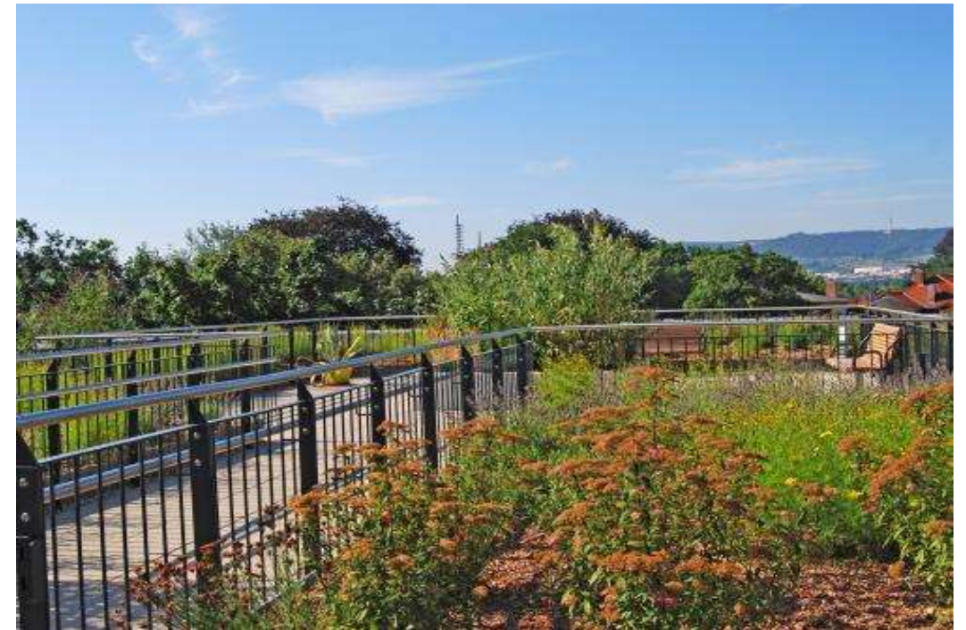
Auflastgehaltenes Geländer, Pflegeheim „Am Villengang“ , Jena (Quelle: ZinCo)
