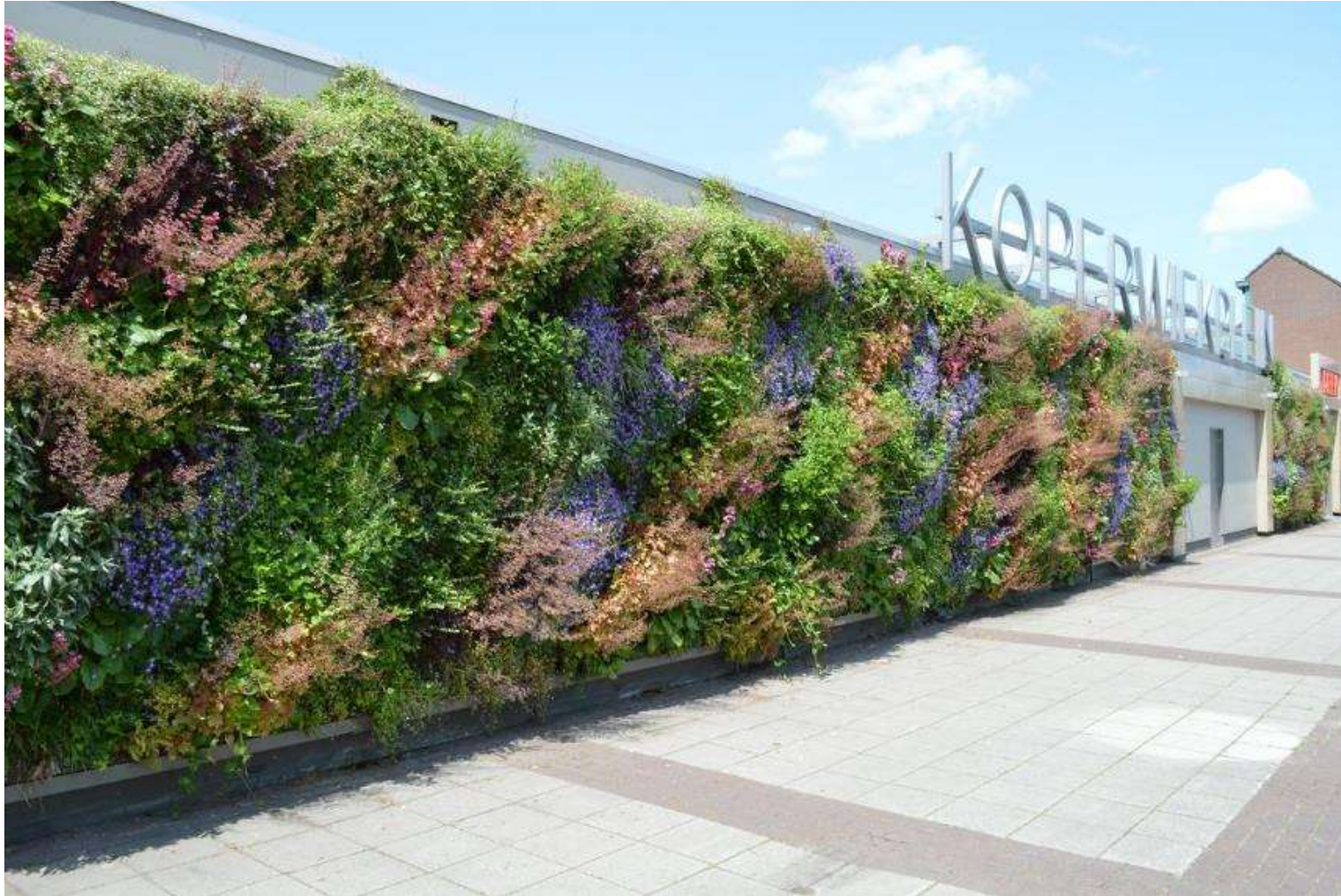
Modulare, wandgebundene Fassadenbegrünung Niederlande. Quelle: Optigrün
