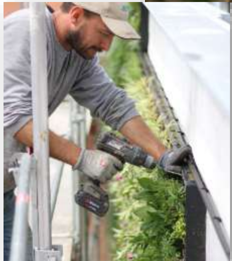
Oben: Anbringung der des Biomura-Moduls beim System Biomura der Fa. Helix Pflanzsysteme GmbH
