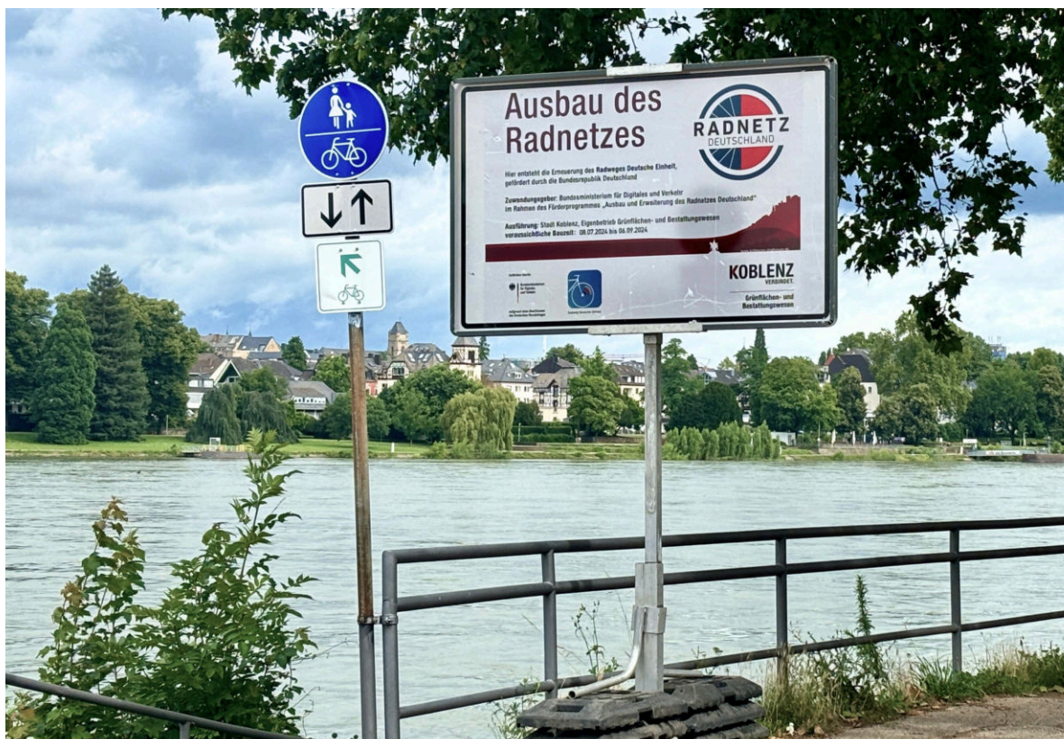
Beginn des Leinpfades unterhalb der Emser Straße in Pfaffendorf vor dem Start der Baumaßnahme
