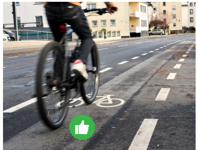
Glatter Belag ohne Rillen und Kanten nach Anwendung des Naht-Remix-Verfahrens
