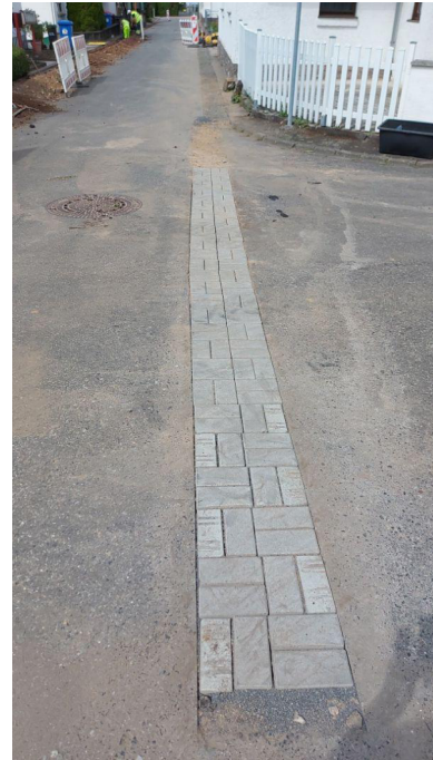
Abbildung 2: Mit Pflastersteinen prov. verschlossene Asphaltquerung
