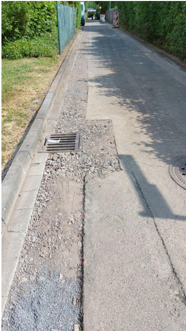
Abbildung 1: Mit Schotter prov. verschlossener Längsgraben in Asphalt
